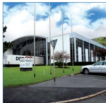
KEUCO Ausstellungsgebäude, Hemer
