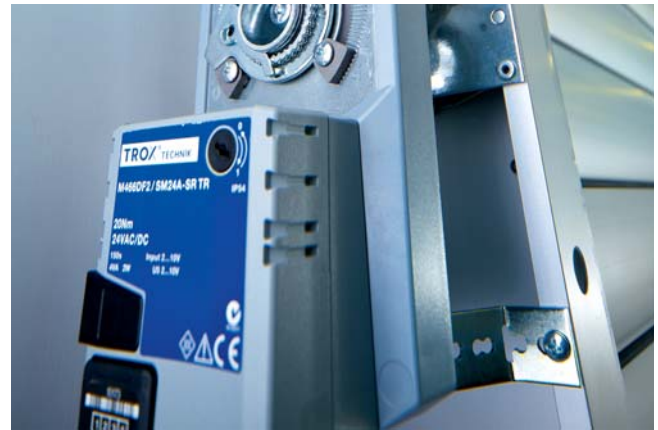
Jalousieklappe mit Stellantrieb
