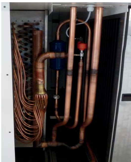
Venturiverteiler des Verdampfers
