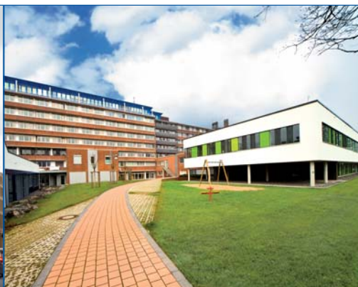
Evangelisches Krankenhaus, Wesel
