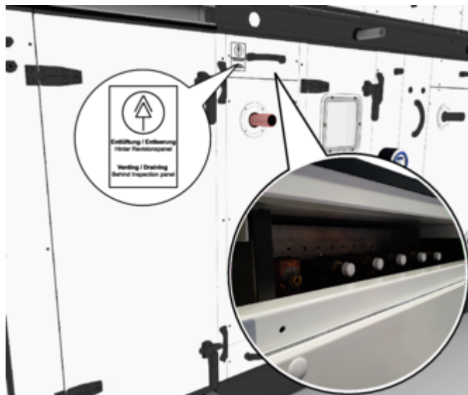
Abb. 24: Beispiel der Entlüftungseinrichtungen hinter kleinem Revisionspanel am X-CUBE
