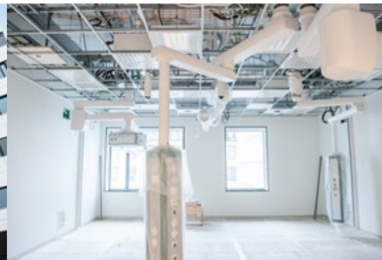
Deckenansicht in einem der hochsensiblen Krankenhausbereiche.
