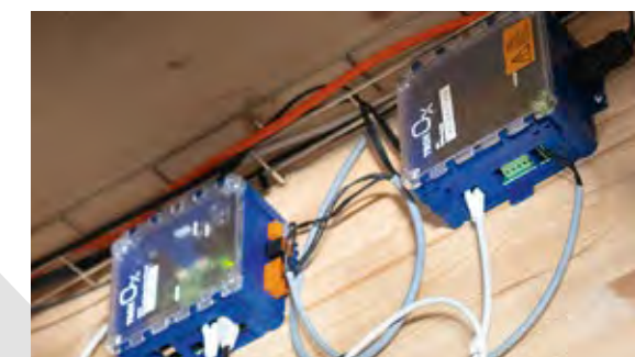
Abb. oben: Schaltschrank mit der hocheffizienten, leicht zugänglichen Technik. Abb. Mitte: Ein einziger System Controller (SC) kann bis zu 125 Zonen, 300 Brandschutzklappen und 500 Volumenstromregler steuern. Abb. unten: links das Field Application Modul (FAM-E) für die Steuerung lokaler Komponenten, rechts der Splitter (SPL) zur einfachen Integration von Volumenstromregler und Peripherie (Ventile, Temperatursensoren).
