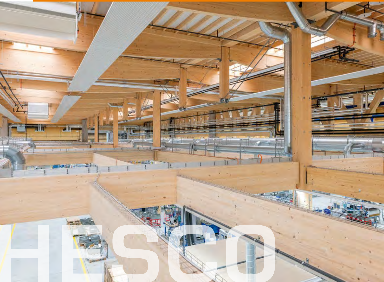
Die 7.000 m 2 große Produktionshalle wurde, wie der komplette Neubau von TROX HESCO in der Schweiz, in nachhaltiger Holzelemente-Bauweise erstellt.
