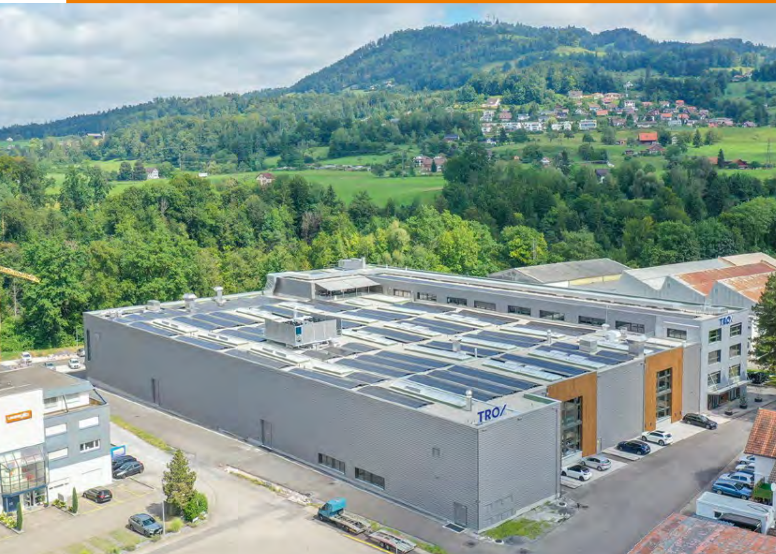
Die 5.000 m 2 große Photovoltaikanlage deckt über 50 % des Strombedarfs von TROX HESCO.
