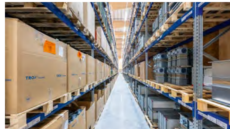
Schmalgang-Hochregallager mit 1.932 Lagerplätzen.
