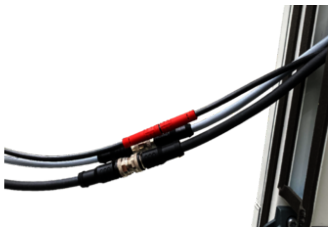
Abb. 38: Verbindung der Leitungen
