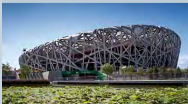
Пекин, 2008: технологии кондиционирования и вентиляции TROX применяются при строительстве Национального олимпийского стадиона, или Птичьего гнезда, как его называют местные жители.
